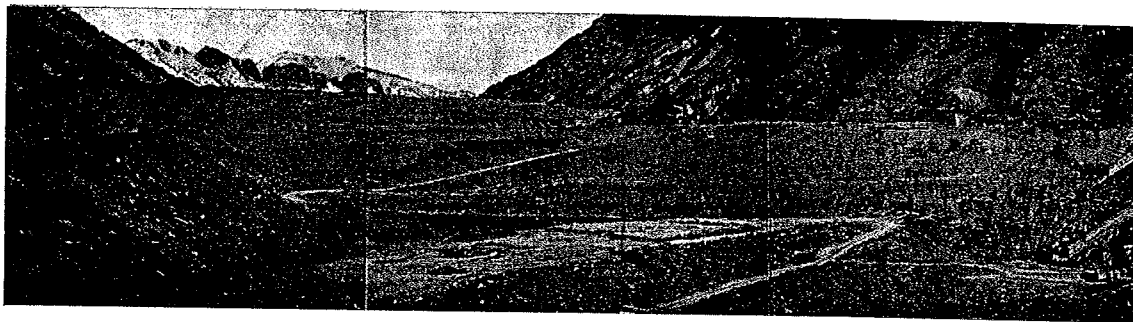
Fig. 2 - Il rilevato diga in costruzione, visto da valle (febbraio 1975). Altezza del contronucleo \sim 205 m.
