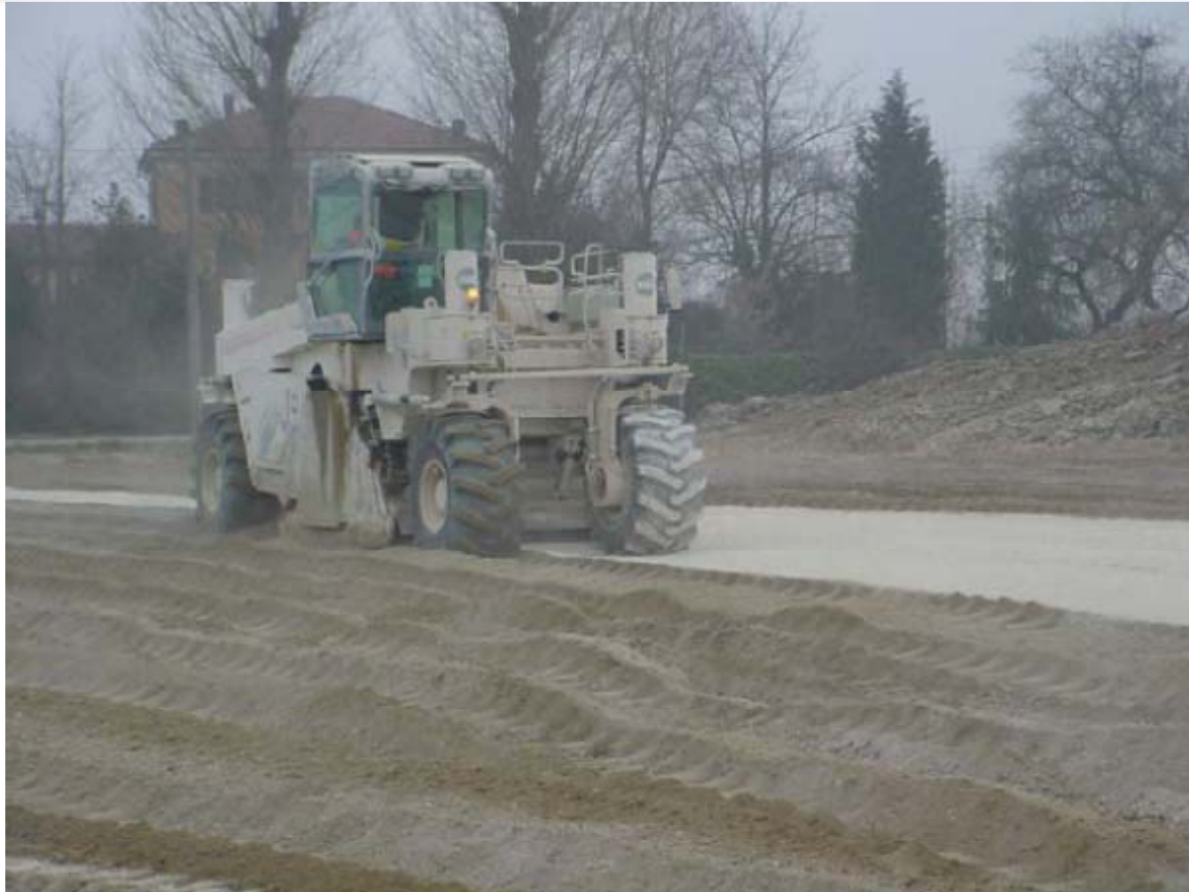
Miscelazione in sito terreno-calce
