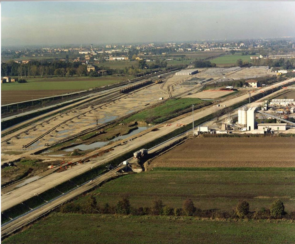
Veduta aerea della linea AC Bologna-Milano in costruzione
