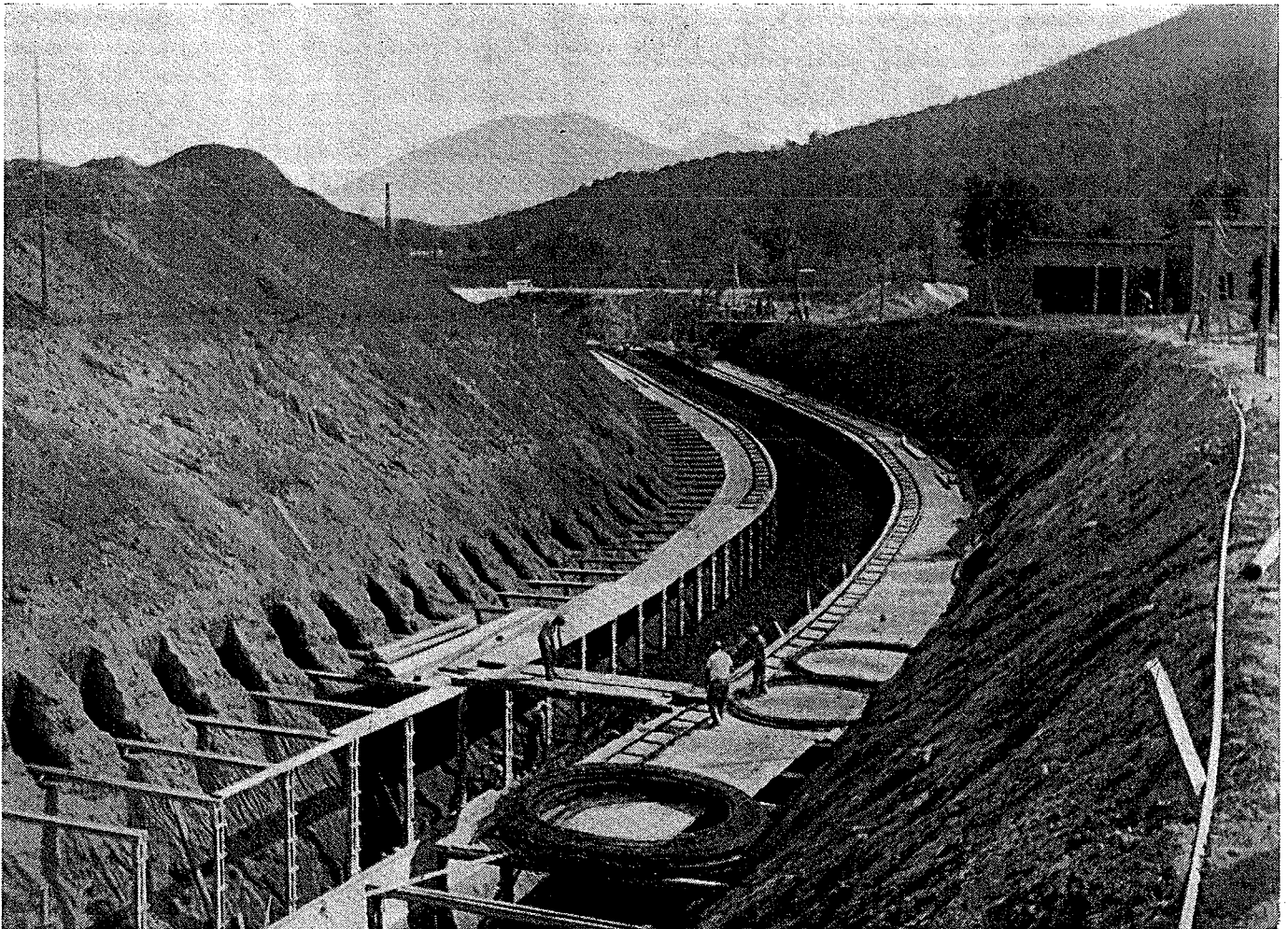
Galleria artificiale in rocce sciolte di origine vulcanica (tufi incoerenti). L'opera fa parte del canale, che deriva in sponda sinistra le acque del fiume Volturno a Ponte Annibale e le convoglia all'impianto di irrigazione della sinistra della piana del Basso Volturno.
