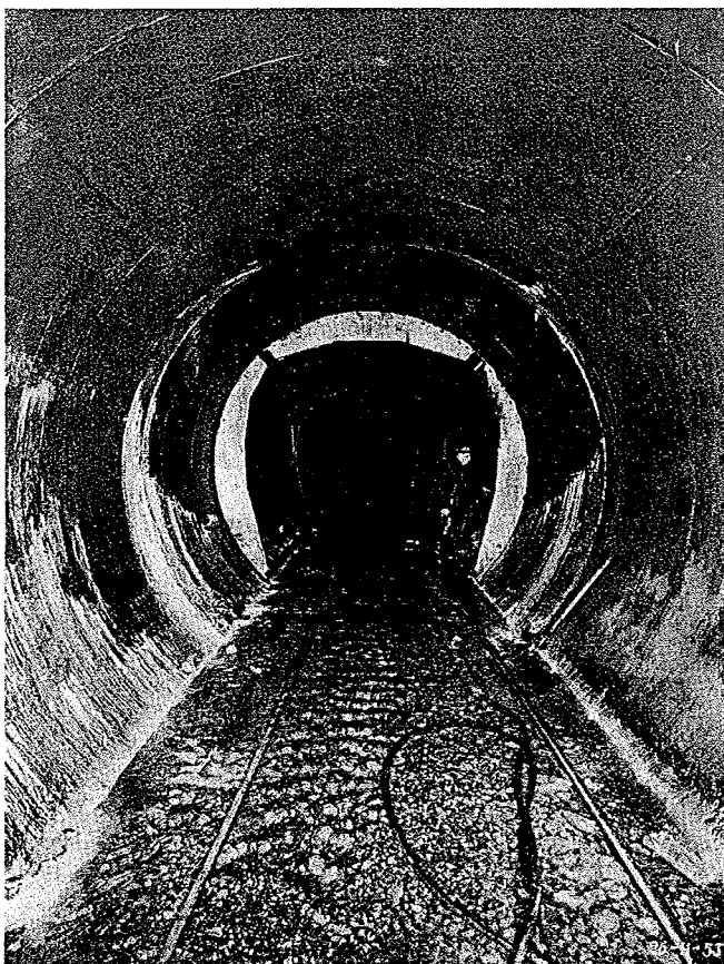
Fig. 3 - Tratto di galleria finita. In platea circa 200 l/sec di acqua.
