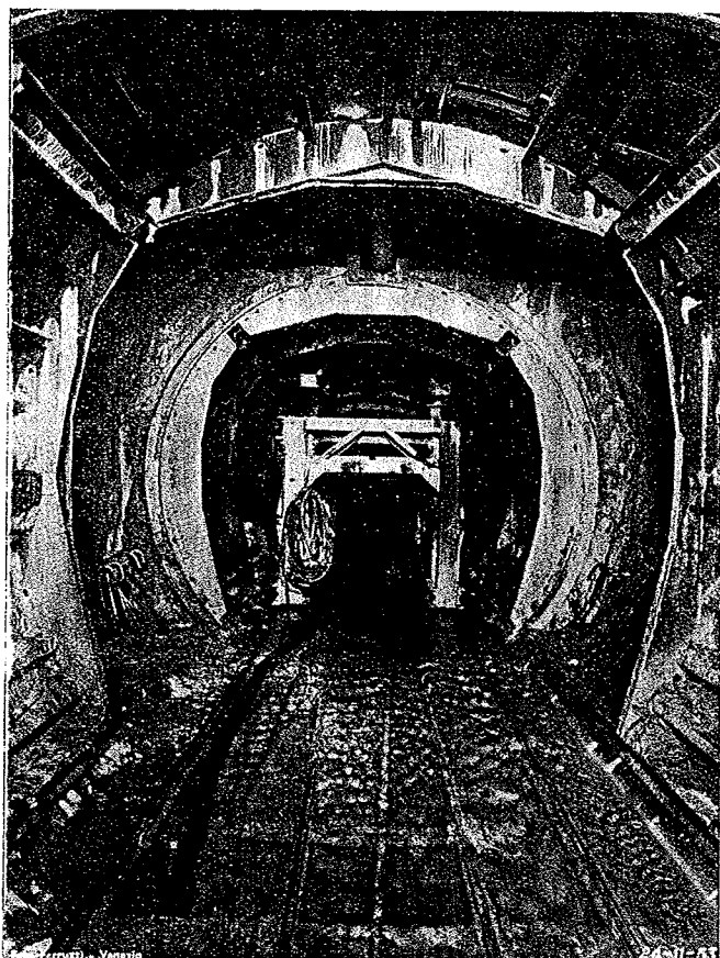
Fig. 1 - Messa in opera di una forma di m 6.
