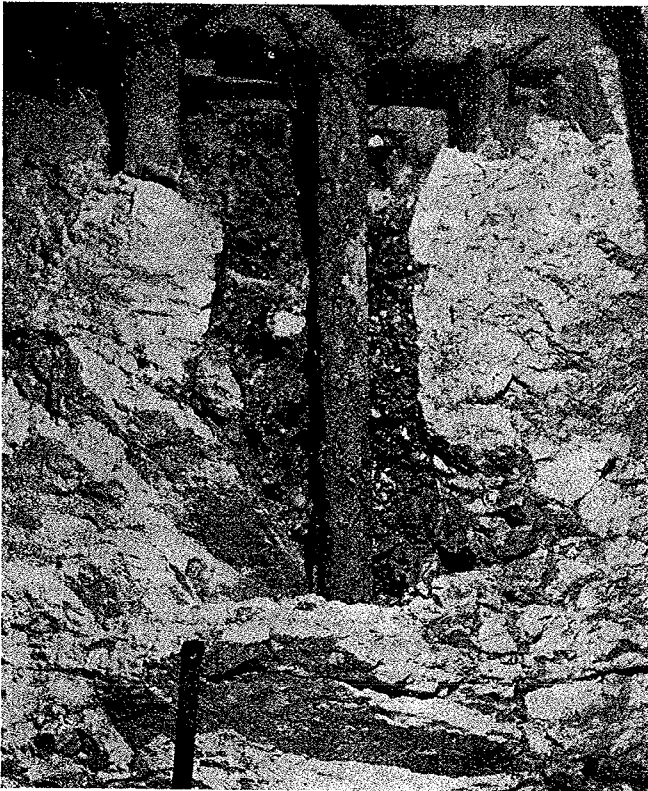
Fig. 7 - Alluvione iniettata del fondo scavo; fronte verso valle.
