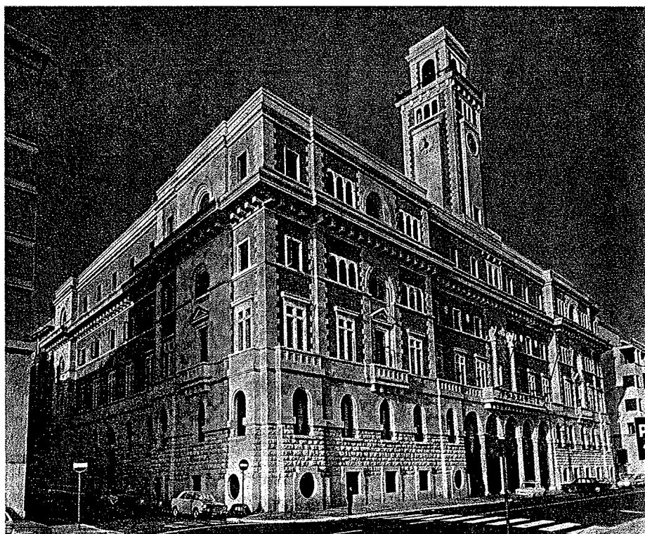
Fig. 2. - Palazzo della Provincia di Bari. Aspetto del palazzo a restauro ultimato.
