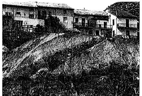
Fig. 3. - Coronamento frana: parte sinistra.
