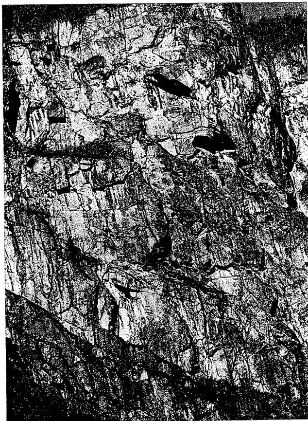
Fig. 6. - Valle Isarco. Versante destro. Veduta della parete corrispondente alla stazione 18. La parte inferiore è interessata da una serie di discontinuità molto estese e mediamente inclinate.
