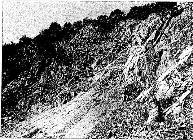
Fig. 3. - valle Isarco. Versante destro. Particolare della figura 2. È visibile sul margine destro la serie di discontinuità molto inclinate, principale causa dei vistosi fenomeni di scivolamento.
