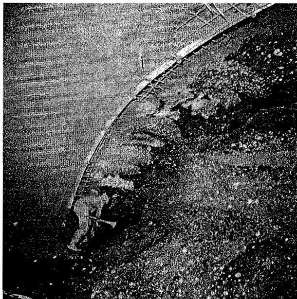
Fig. 10 - Galleria di Bad-Godesberg. Vista dell'arco di terreno consolidato durante lo scavo.
